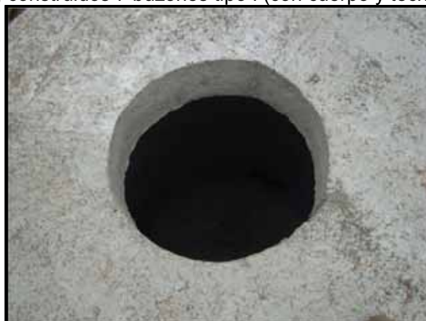
Foto N°2: Vista de techo buzón construido en la AA.VV Gardenias.
