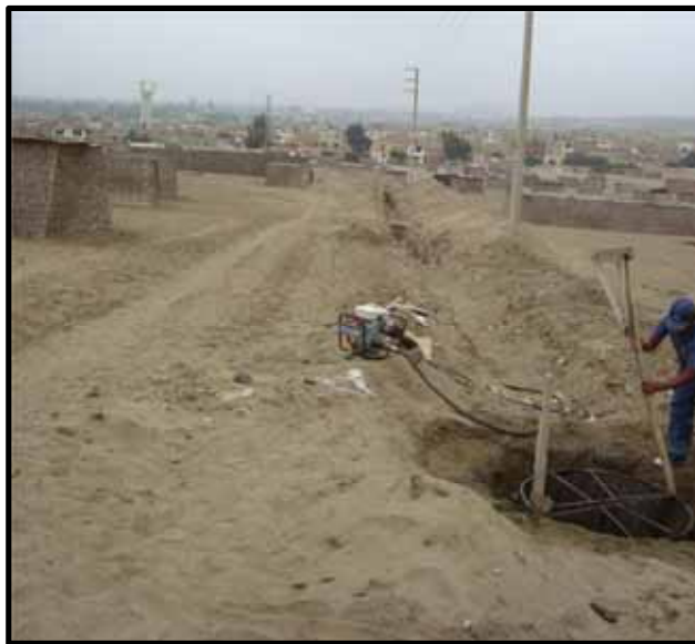
Foto N°1: Excavación de zanja que cruza la AA.VV Gardenias
